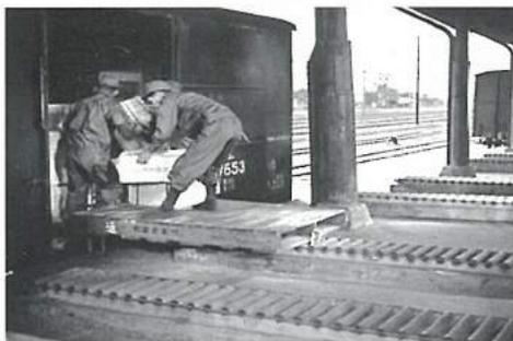
映画「荷役はかわる一通運のパレット作業」※(1958年/制作：岩波映画製作所)より。パレットとローラコンベアによる荷役作業。
