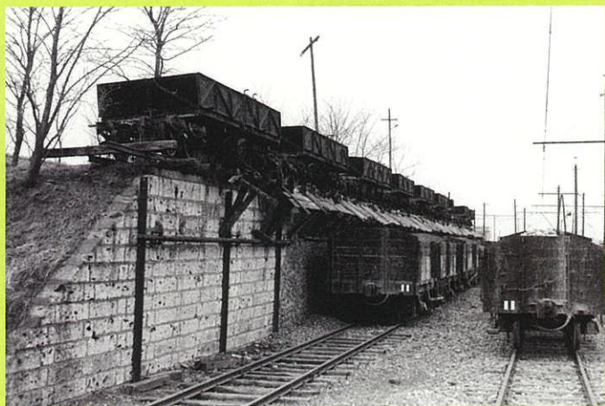
西武多摩川線・競艇場前駅の砂利積み替え設備 昭和36年(1961)1月29日
