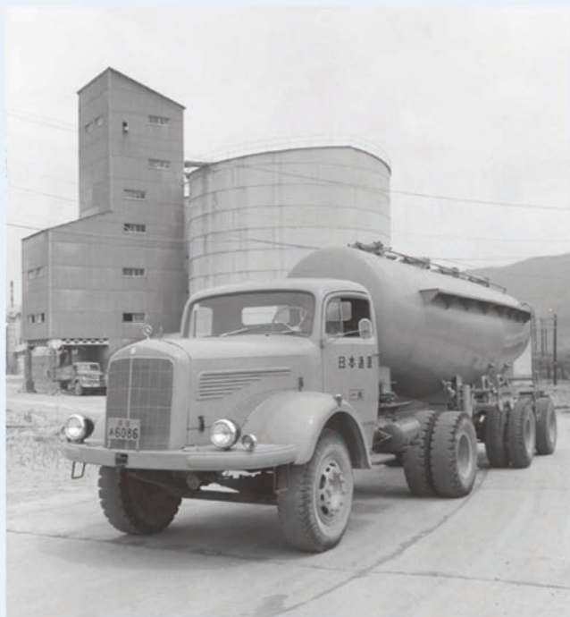
黒部ダム建設用のセメントサイロとセメント輸送用トレーラー 昭和34年（1959）
